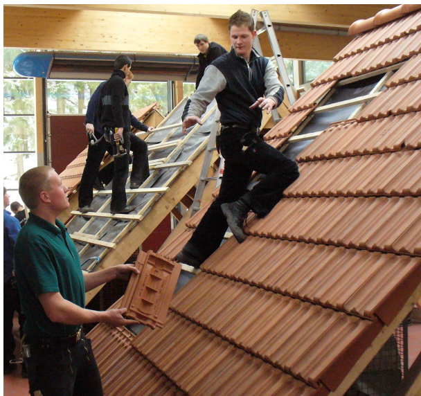
Bsp.: Dacheindeckung mit verfalzten Ziegeln
